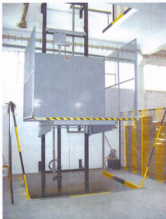
• Estrado de um monta-cargas para 10000 kg, com 7 x 3 m
